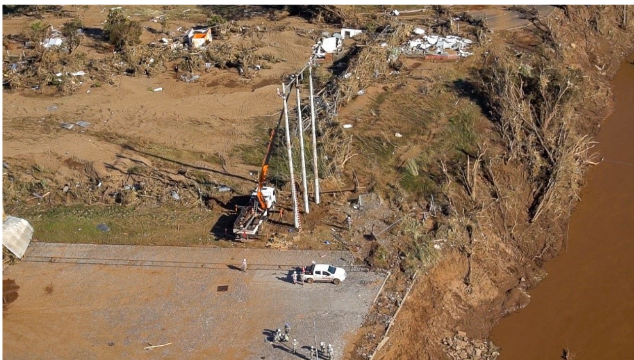
Figura 2 – Reconstrução de linha e vegetação derrubada pela força das águas durante as enchentes.
